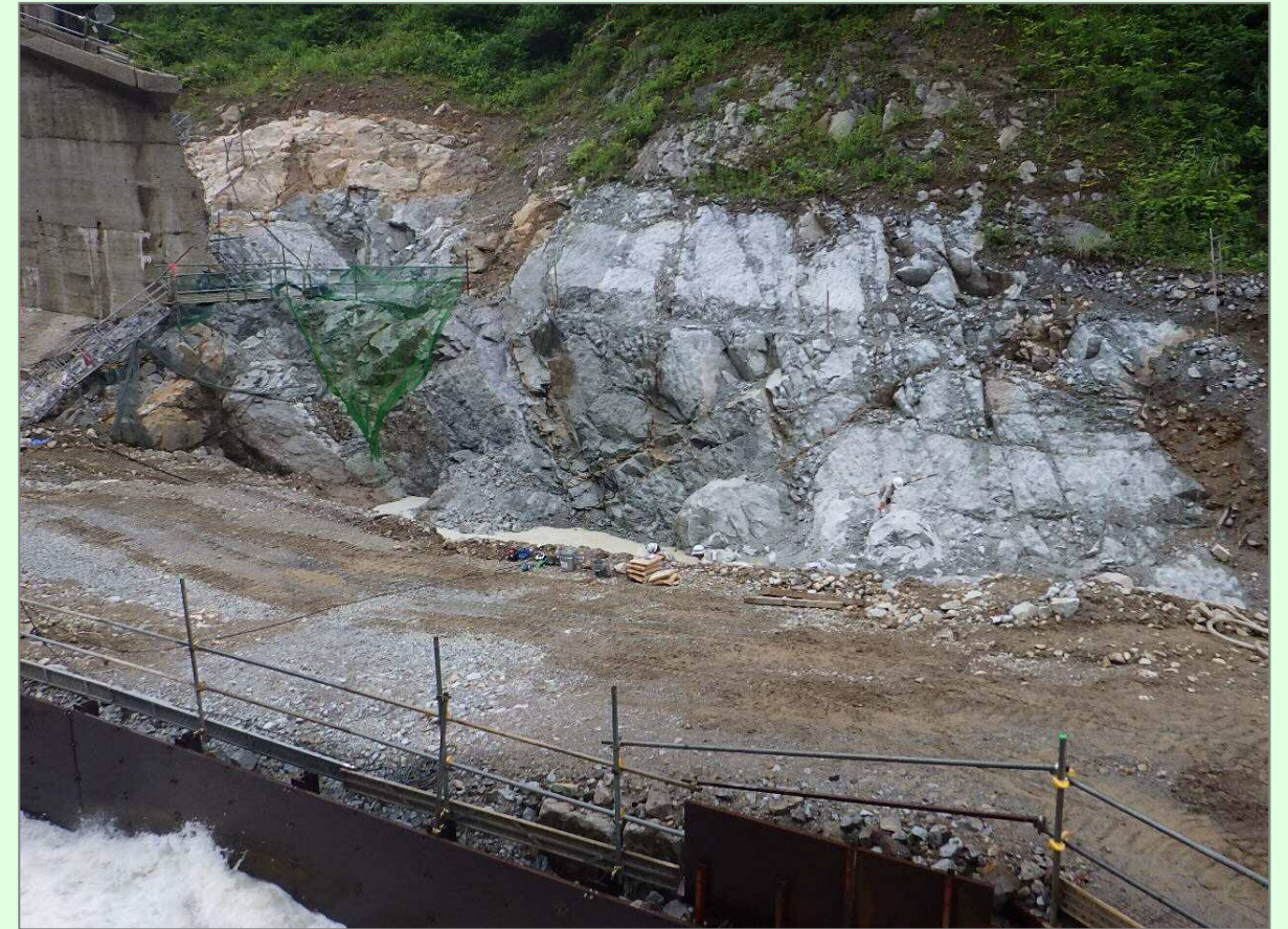
減勢工施工状況
