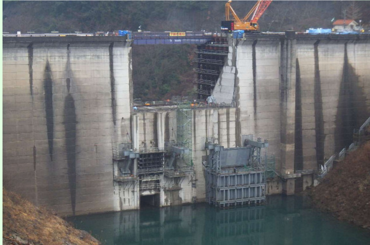
上流仮締切施工状況
