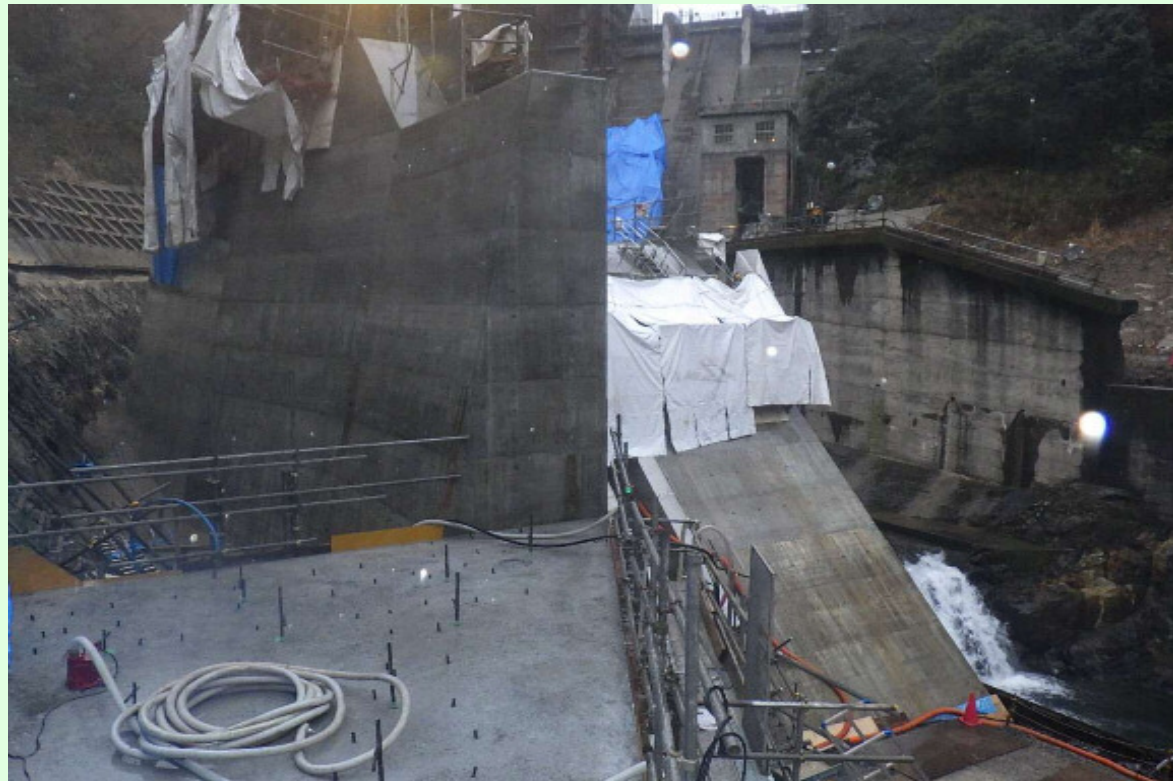
右岸副ダム施工状況
