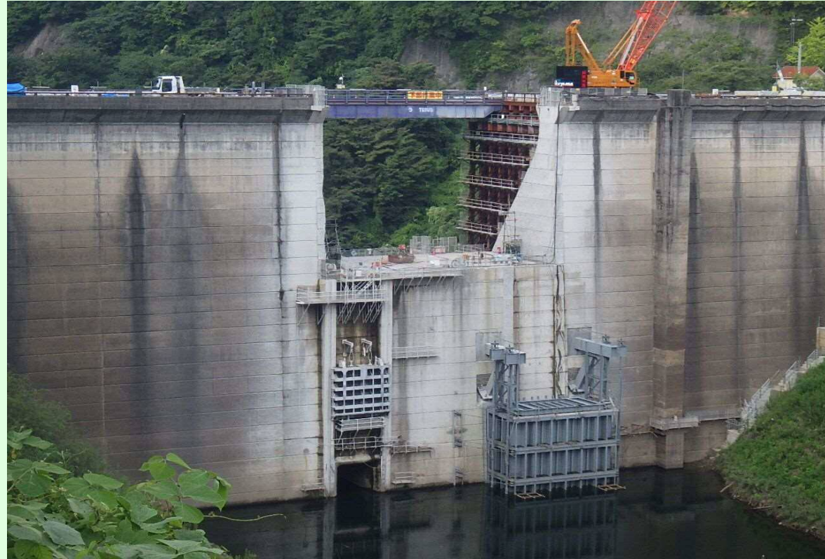
堤頂部既設取壊し及び右岸上流仮締切状況
