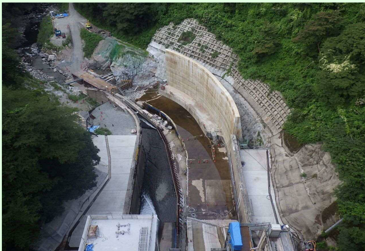
減勢工・工事用道路
