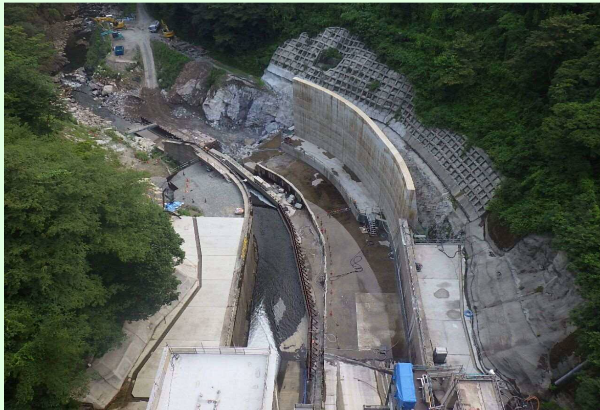
減勢工・工事用道路
