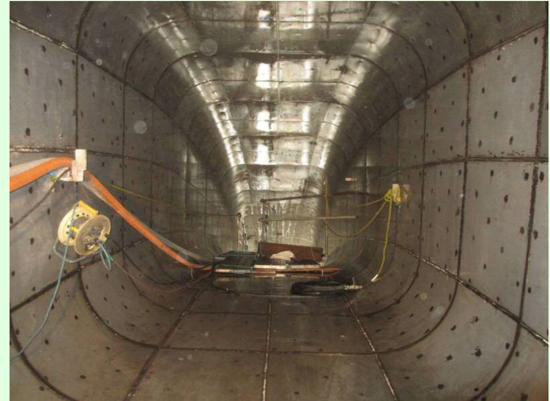
右岸放流管改造状況
