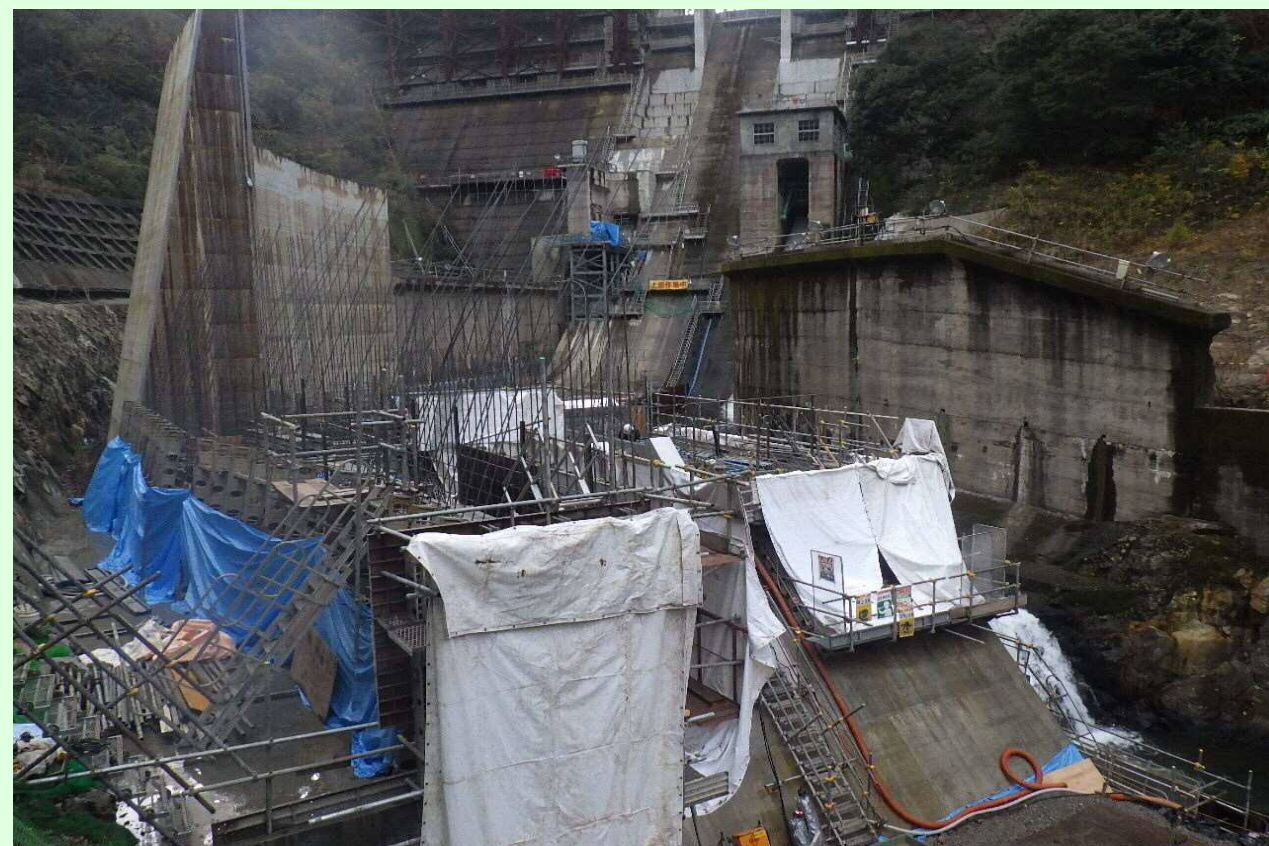
右岸副ダム施工状況
