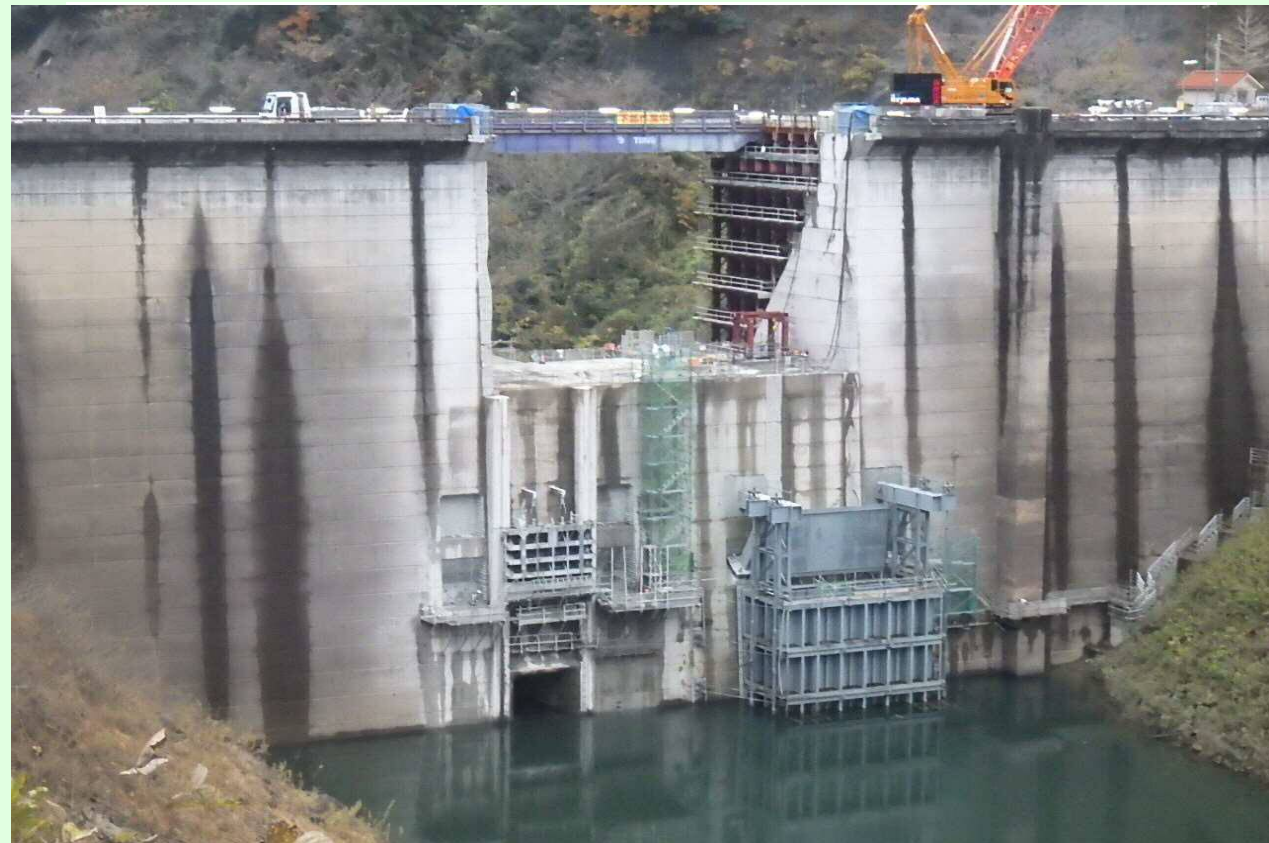
上流仮締切施工状況
