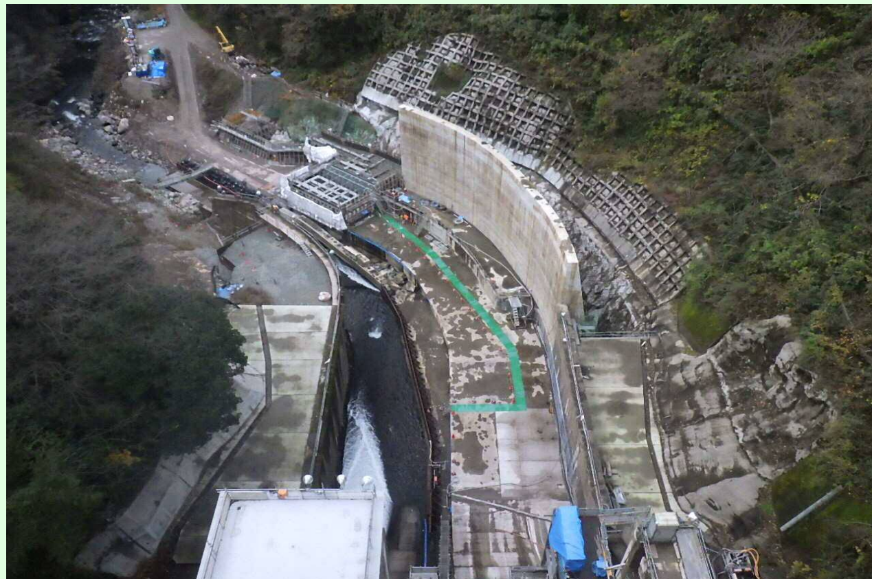
減勢工・工事用道路
