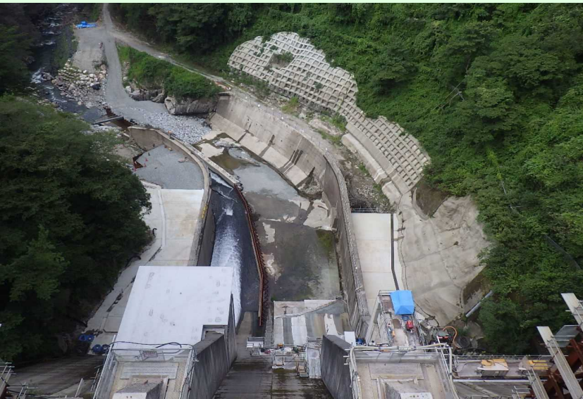
減勢工・工事用道路
