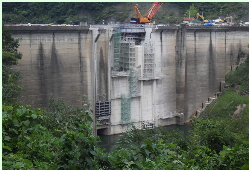
堤頂部既設取壊し状況
