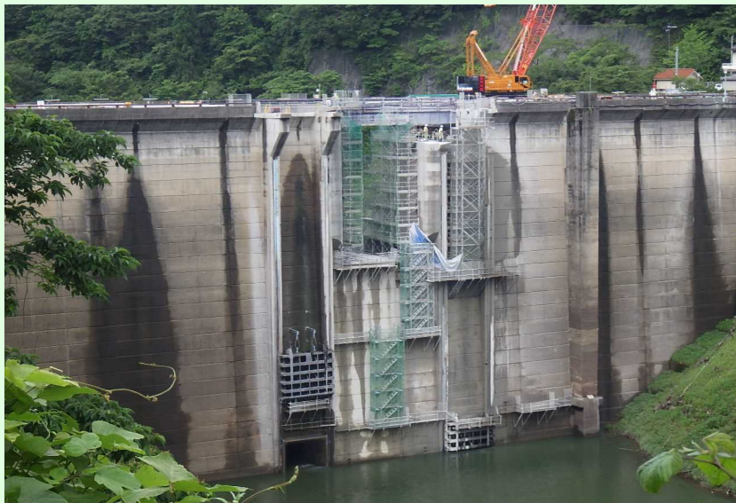
堤頂部既設取壊し状況
