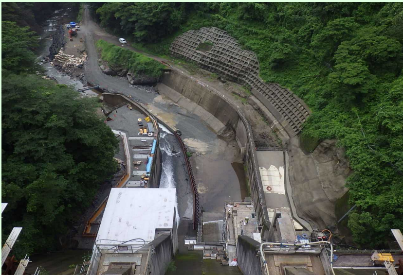
減勢工・工事用道路
