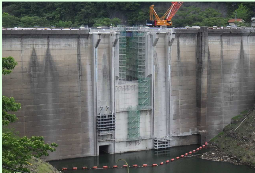
堤頂部既設取壊し状況
