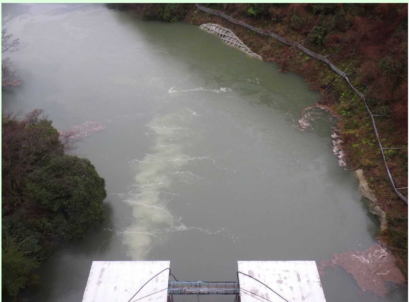
減勢工・工事用道路
