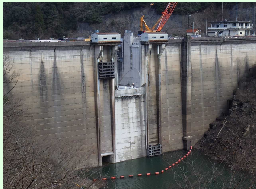
堤頂部既設取壊し状況
