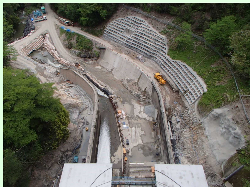
減勢工・工事用道路
