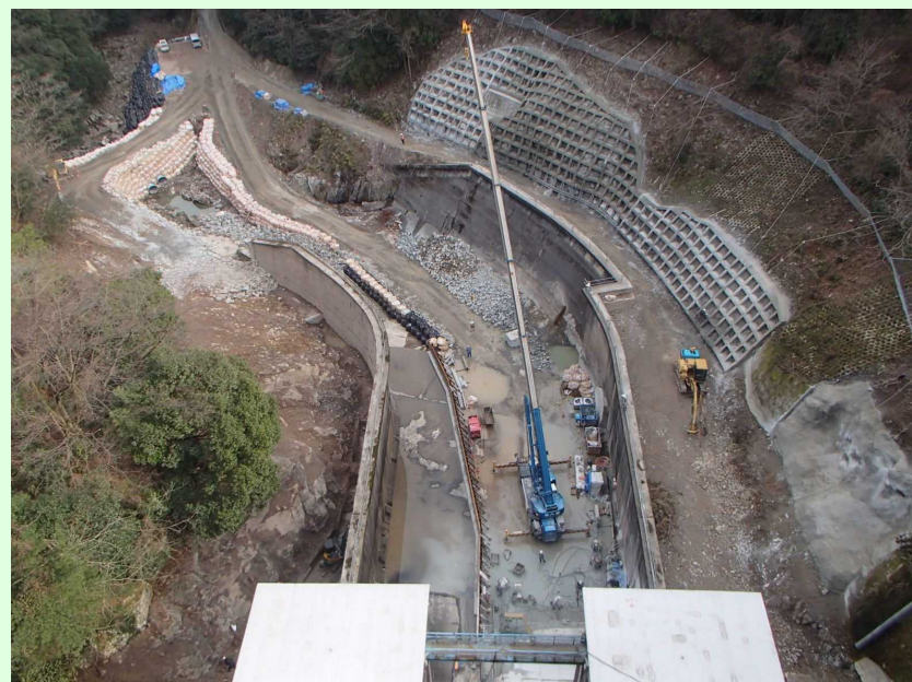
減勢工・工事用道路
