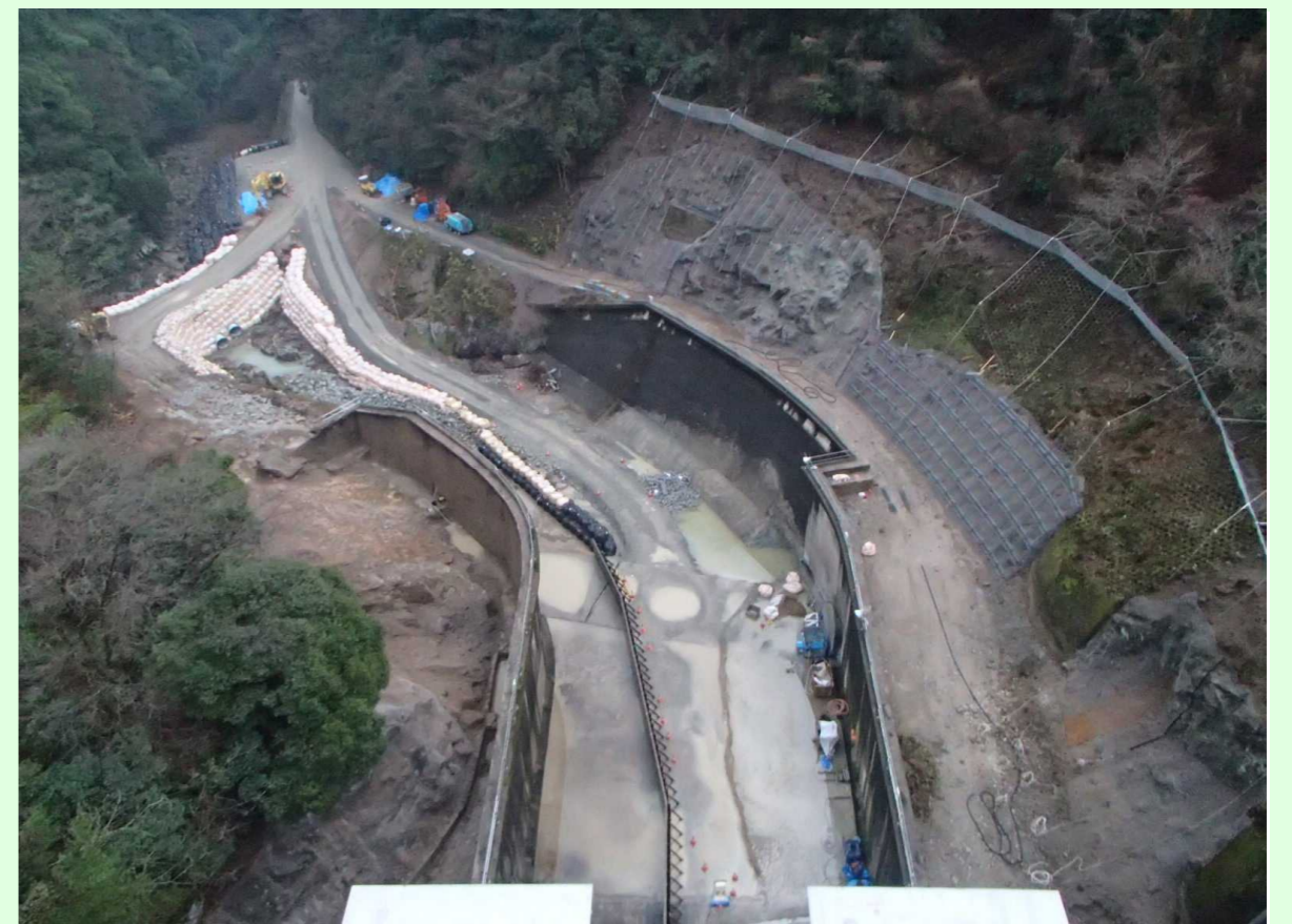
減勢工・工事用道路
