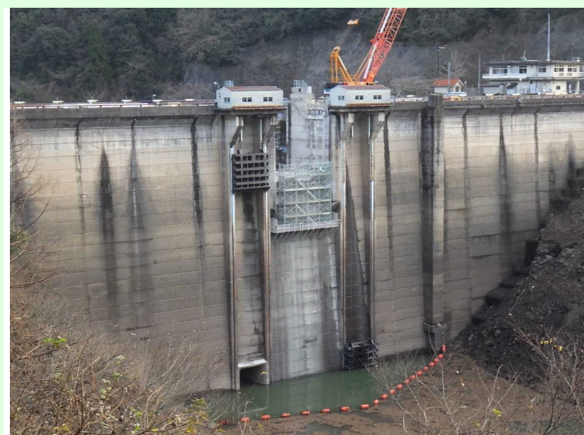
堤頂部既設取壊し状況
