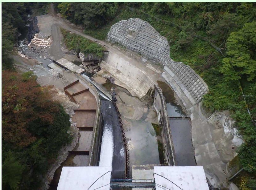
減勢工・工事用道路
