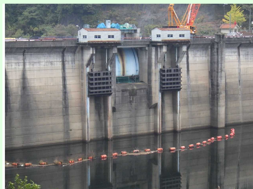
堤頂部既設取壊し状況
