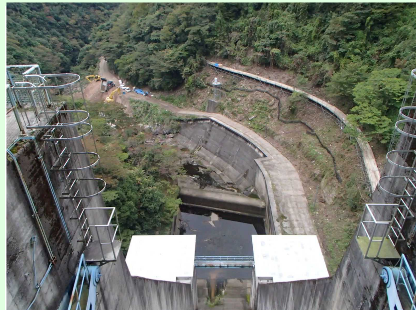
減勢工・工事用道路
