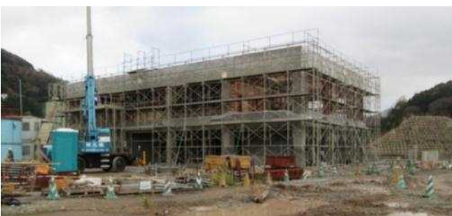
管理所建設工事の進捗状況
