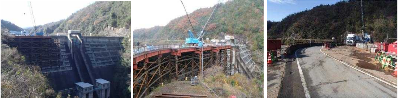
仮設構台設置状況
