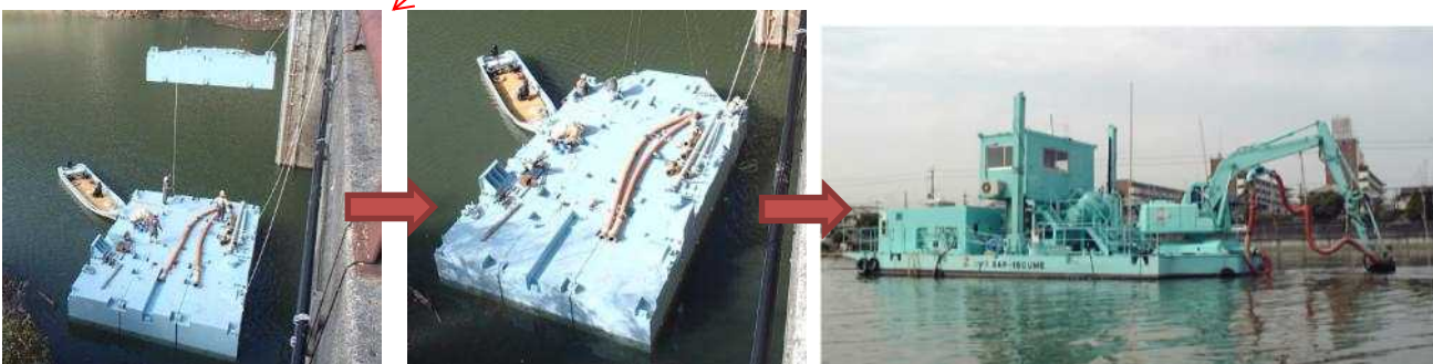
(真空吸引圧送船 組み立て状況)
