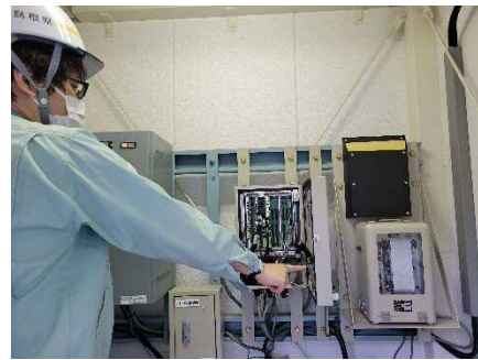
定期点検の様子
