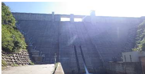
下から見た第二浜田ダム
