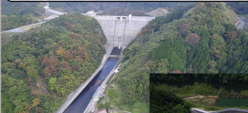
第二浜田ダム
