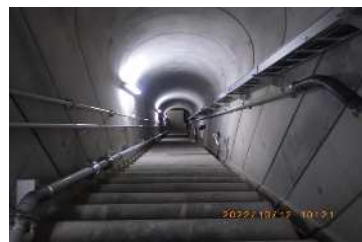
ダムの内部（監査廊）
