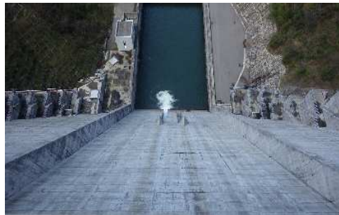
上から見た第二浜田ダム
