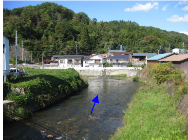
⑤来島大橋下流 (小田川合流点下流)
