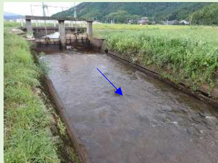
西中津水門付近
