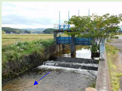
一本松頭首工
