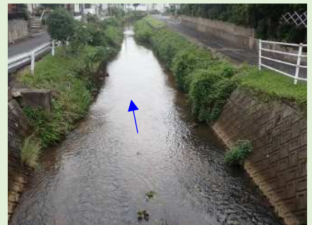
木戸川橋下流
