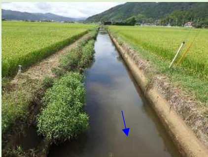
中津水門付近
