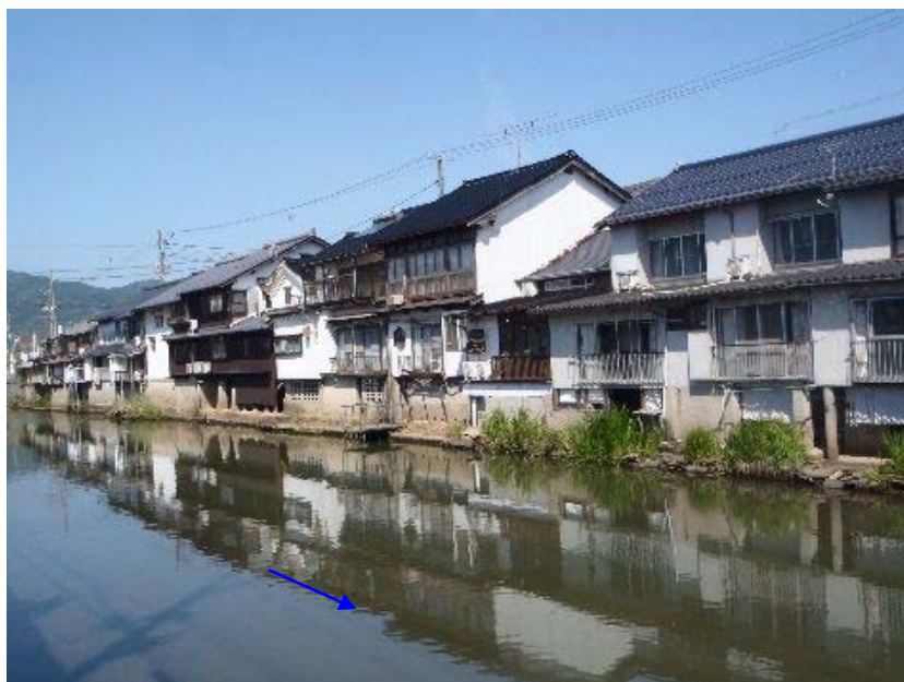
写真-3.2.2 新大橋上流左岸（掛け出し）
