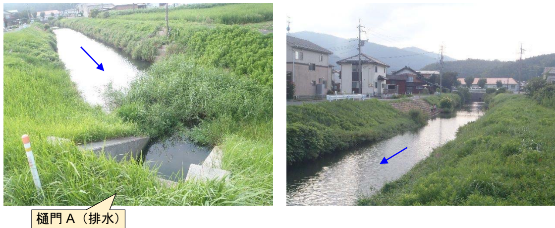
写真-1.1 A 区間河川現況
