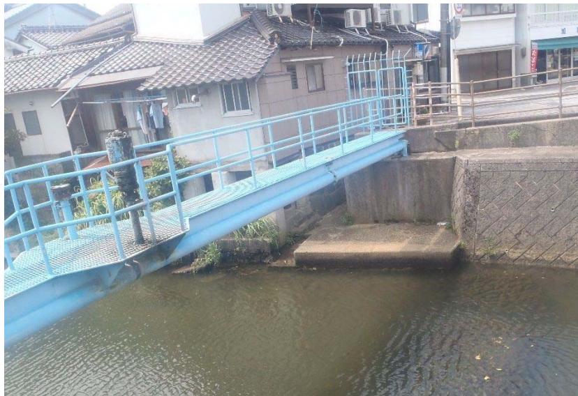
写真-3.2.6 共有の掛け出し
