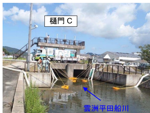
写真-3.3.16 ポンプ車稼働状況 （河口より約 700m 地点）
