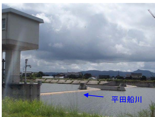
写真-3.3.15 平田船川汐止堰の起立状態 （河口より約 700m 地点）
