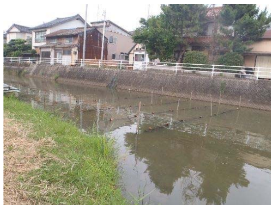
写真-3.3.14 炭素繊維設置状況 (平成 26 年度)
