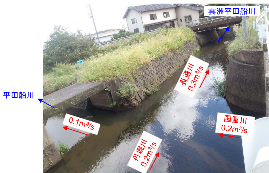
写真-3.3.10 丹堀川・長通川と国富川の交差点 (流量は平成 29 年 9 月 13 日観測)
