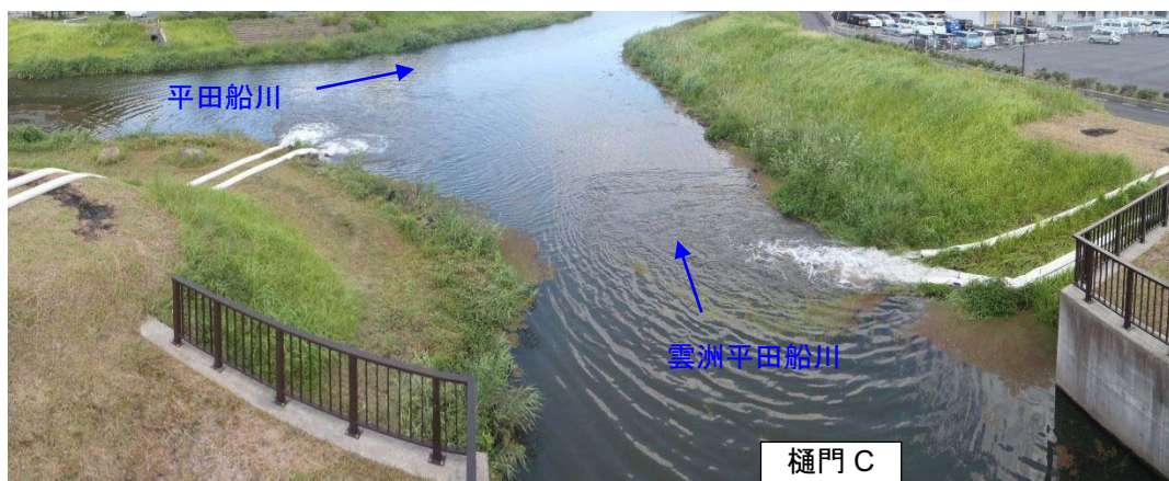
写真-3.3.17 平田船川へのポンプ車からの排水状況
