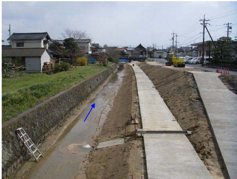
写真-3.3.3 小断面化施工状況（第2交友橋下流）
