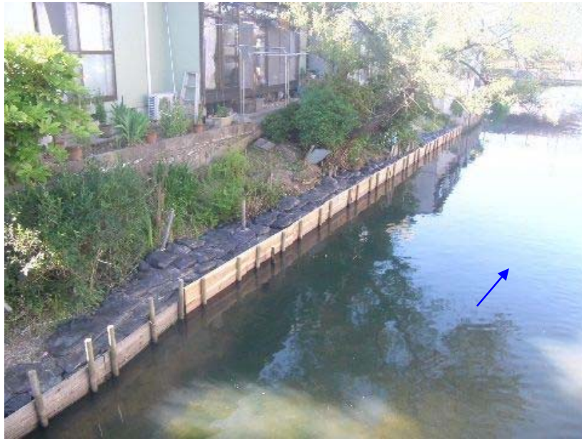
写真-3.2.7 崩落対策状況（平成 29 年度応急工事）
