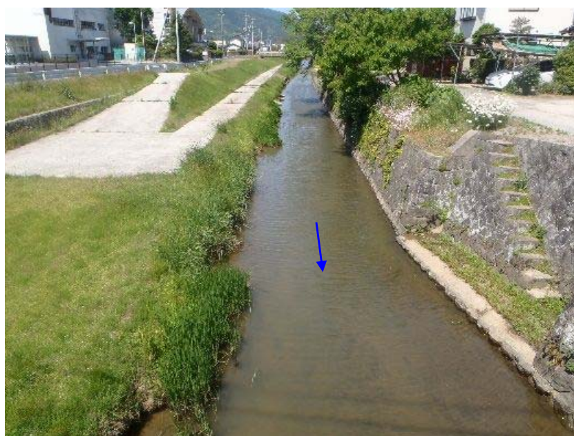
写真-3.3.5 B 区間現況（下流部）
