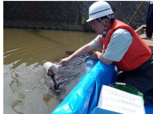
写真-3.3.12 水質浄化剤散布状況 （平成 26 年度）
