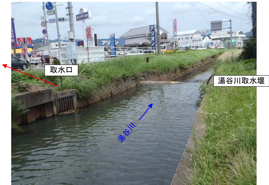
写真-3.3.6 湯谷川取水堰（起立時）
