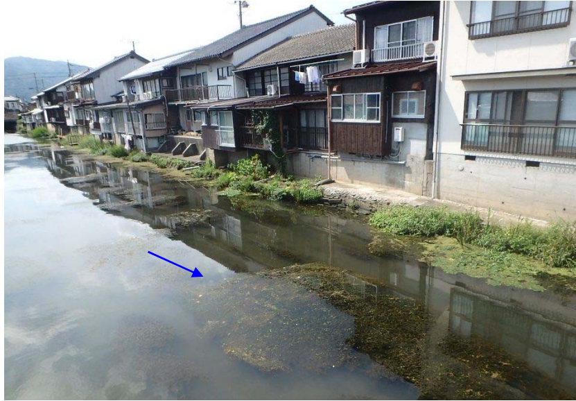
写真-3.2.3 河岸の崩落状況（全景）
