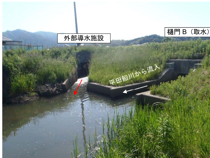
写真-3.3.7 B区間上流端
