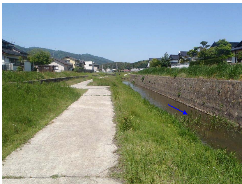
写真-3.3.4 B 区間現況（上流部）
