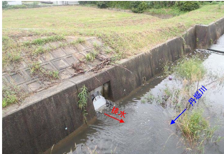
写真-3.3.9 丹堀川への排水 (流量は平成 29 年 9 月 13 日観測)
