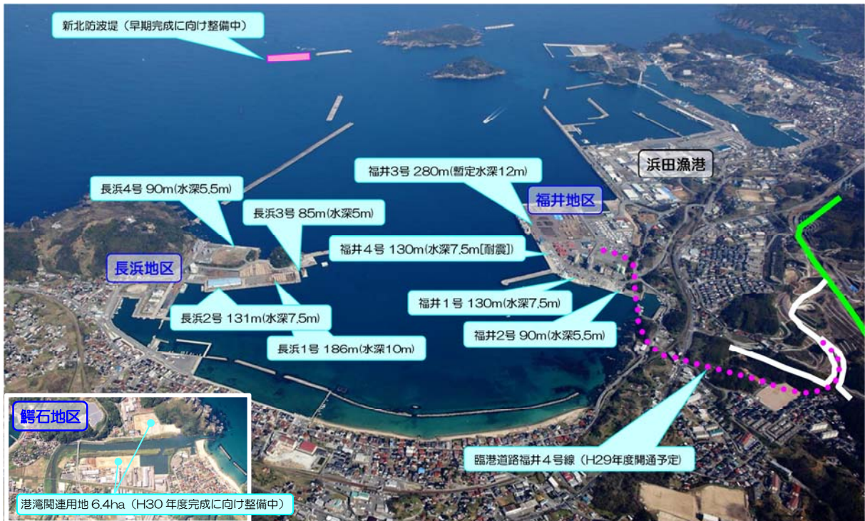
図 1-3 浜田港の主な港湾施設
