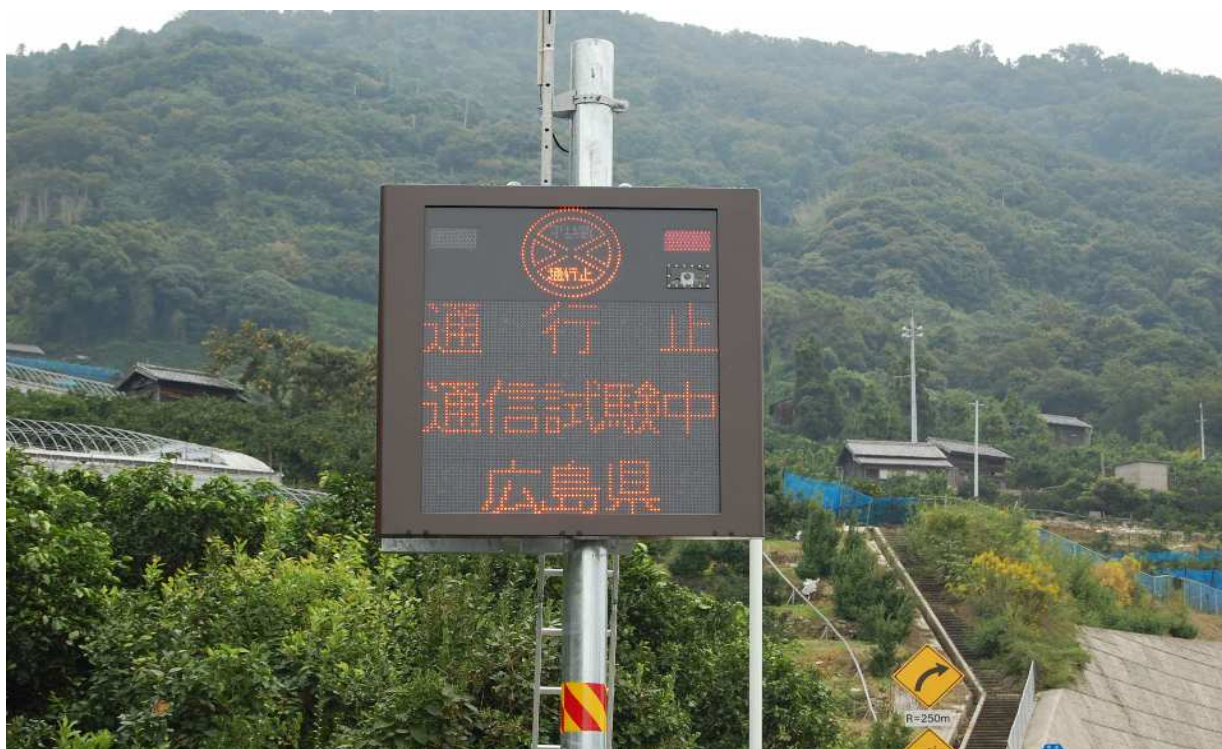
異常気象道路表示板
