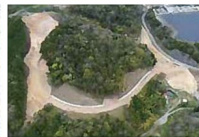
(主)浜田八重可部線 後野工区(浜田市後野町)
