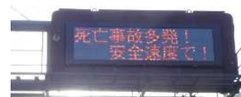
ロービーム LED が組み込まれた道路情報提供装置
