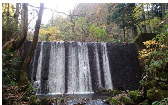
写真4 魚道の無い砂防堰堤
