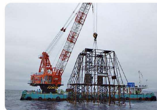
ぎょじょう ちんせつ 魚礁の沈設
