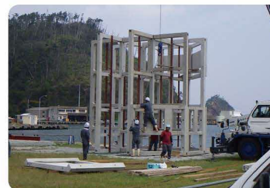
ぎょじょう くみたて 魚礁の組立
