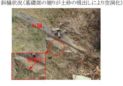
下流側法止ブロック状況(斜樋廻りからの漏水)
