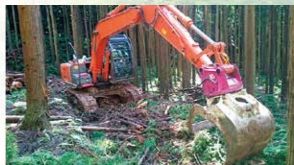
丸太運搬のための作業道を開設
