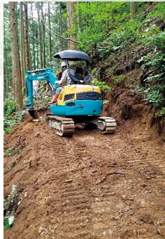
壊れない作業道の作設作業中
