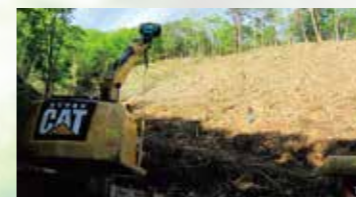
スイングヤードによる集材作業
