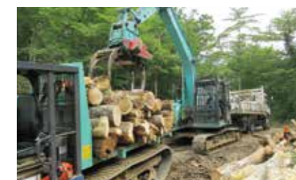
運搬車による運搬作業
