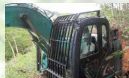
ユニックによる作業道開設作業
