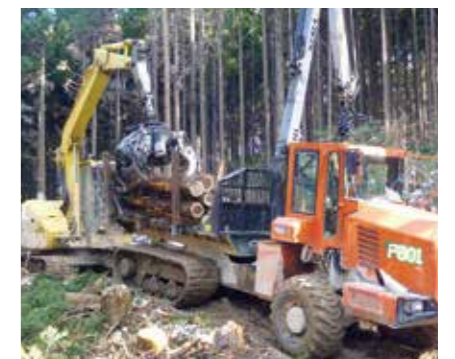
利用間伐の現場
