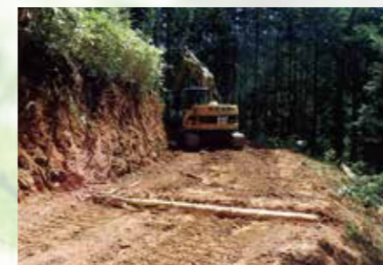
作業道開設作業
