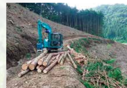
伐採木搬出作業
