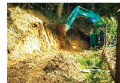
作業道開設作業
