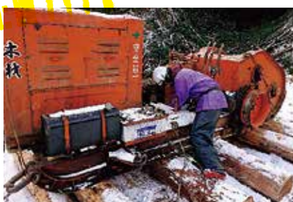
集材機の架設作業
