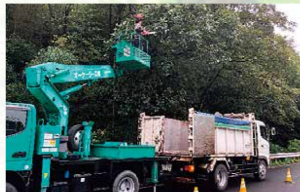
高所作業車による伐採
