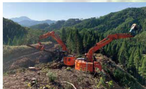
高性能林業機械による主伐
