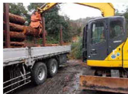
原木積み込み作業
