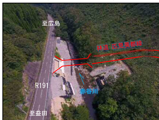
○起点付近（令和 2 年 7 月撮影）
