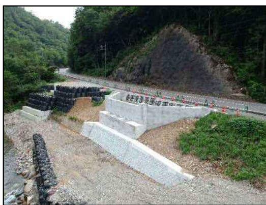
○左岸橋梁下部工（令和 2 年 7 月撮影）
