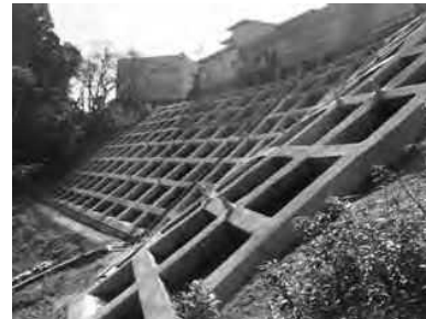
【地すべり工事】 法枠工 アンカー工
