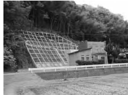
【山腹工事】 法枠工 落石対策
