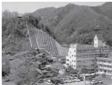
治山施設（山腹工）
