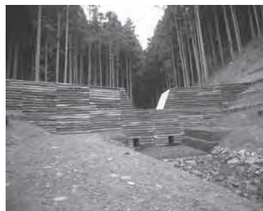
治山施設（治山ダム工）
