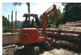
丁寧な重機の取扱
