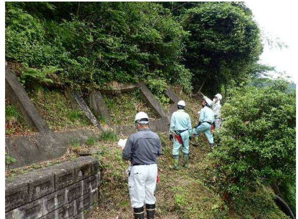
山腹工(法枠工)を点検中
