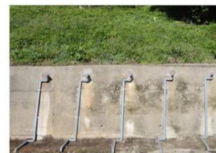
地下水排除工
