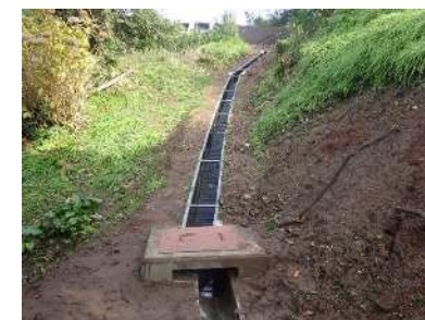
地表水排除工
