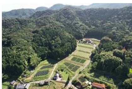
〈中山間地のほ場整備〉
