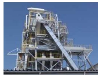
<木質バイオマス発電所>
