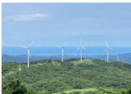
〈風力発電施設（保安林解除）〉
