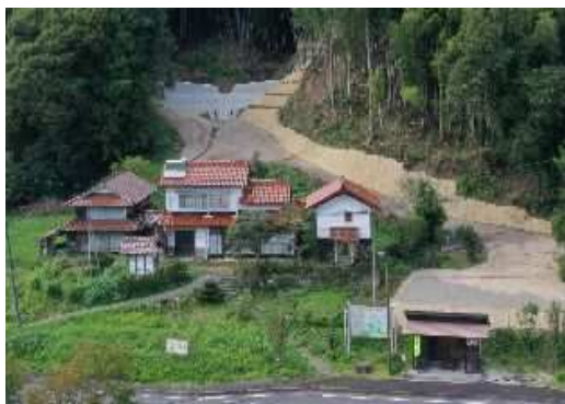
〈治山ダムにより保全された人家〉
