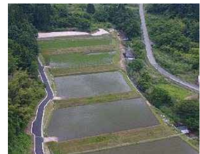
〈中山間地域の小規模なほ場整備〉
