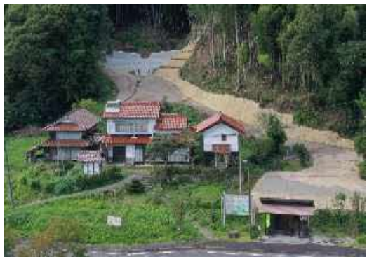
〈治山ダムにより保全された人家〉
