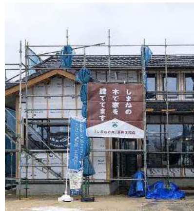
〈県産木材を使用した木造住宅〉
