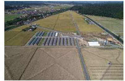
〈大区画に整備されたほ場〉
