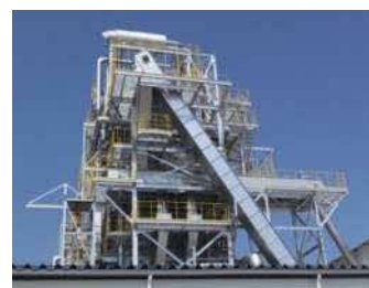
<木質バイオマス発電所>
