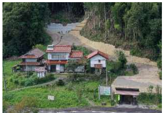
〈治山ダムにより保全された人家〉
