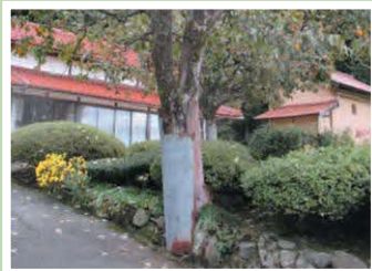
トタン板巻き付け
