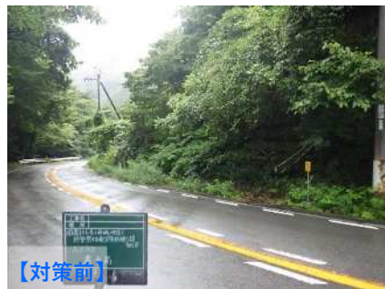
落石防護柵 (R186 金城町長田)
