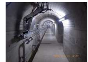
ダムの内部 (監査廊)
