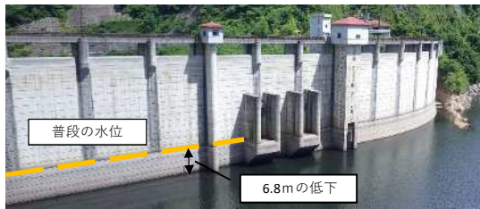
渇水時の状況 (堤体)
