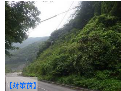
落石防止網 コンクリート吹付 (浜田美都線 浜田市鍋石町)
