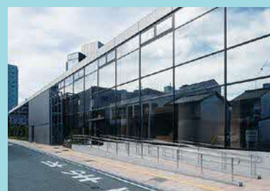
屋外スロープの設置事例
